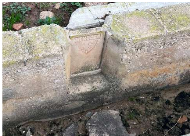
CAIXER DE FORMIGÓ
