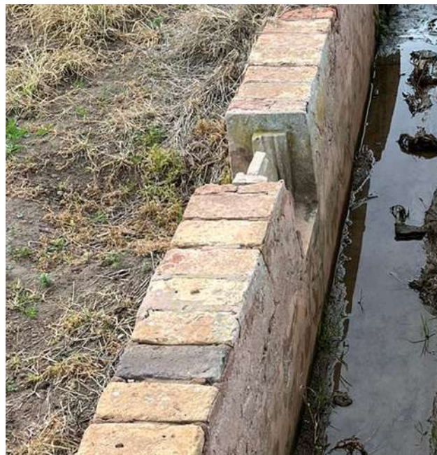
MURS DE MAMPOSTERIA
