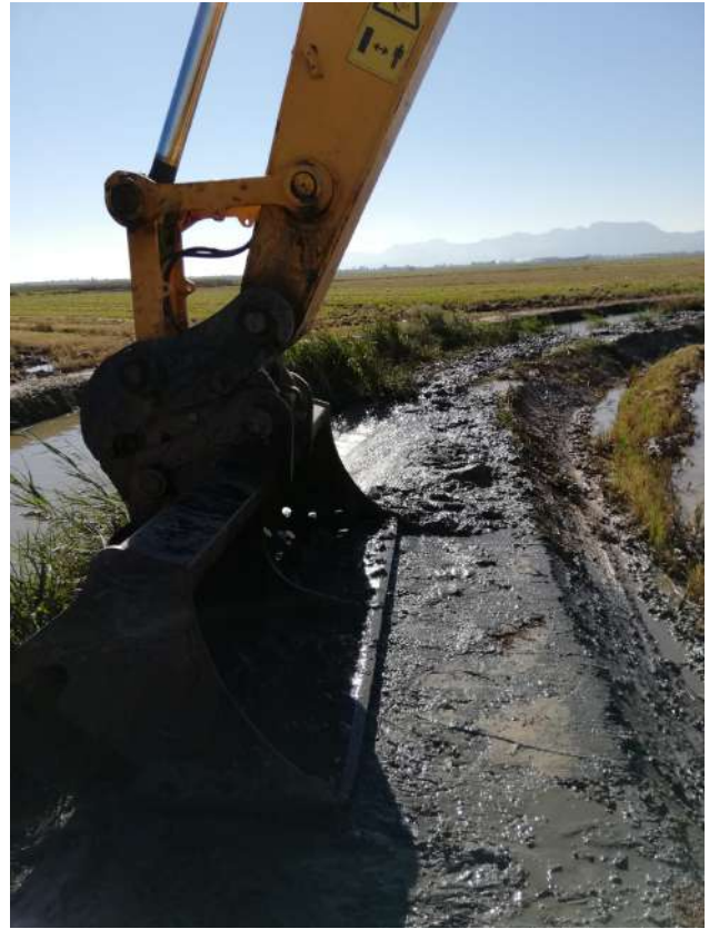
DRAGAT D'UNA SÉQUIA I REPARACIÓ DE LA MOTA
